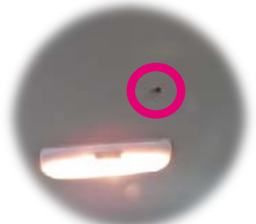
BESCHÄDIGTER DACHHIMMEL (LOCH)
